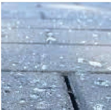
**COSA FA?** - Rende le superfici idrorepellenti. Impedisce l'assorbimento d'acqua e umidità. Previene la formazione di efflorescenze saline. Protegge dai cicli gelo/disgelo, formazione di alghe, muffe e microorganismi.
